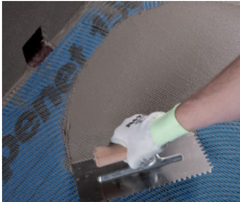
Laying Mapelastico Zero on Mapenet 150
